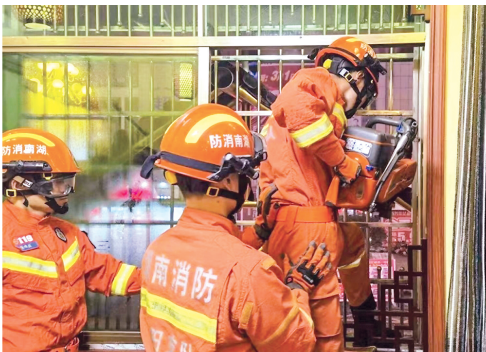
消防人员拆除违规设置的防盗窗。
