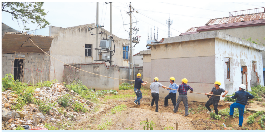
5月20日,岳阳楼区禁违办出动50名执法人员,对望岳路街道内的4处违法建筑开展集中拆除行动。据了解,这4处建筑均为禁违巡查大队和望岳路街道禁违中队日常巡查发现,通过下达停工、限期拆除通知书,社区工作人员上门劝导,做到文明拆违。花江柳 摄
