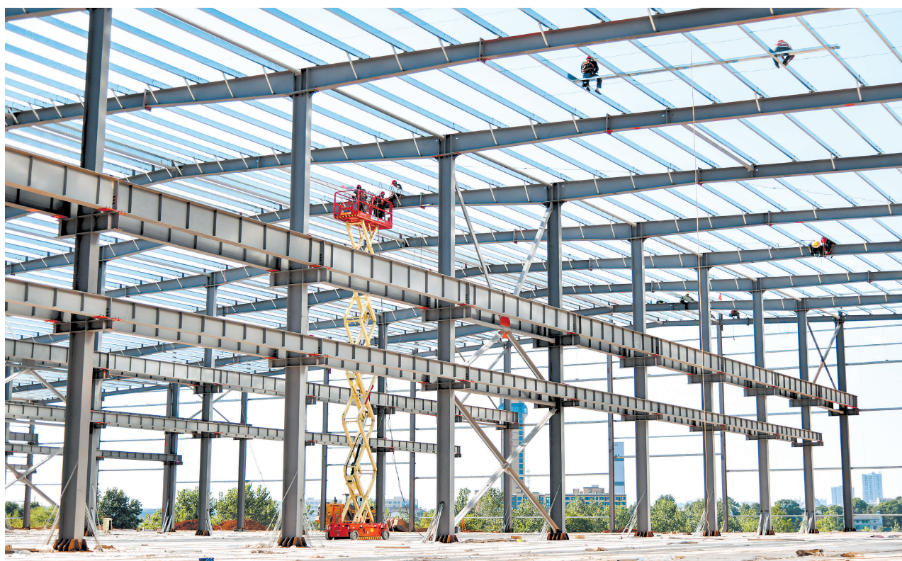
图为建设中的凯博杭萧基地。郭雨滴 摄
