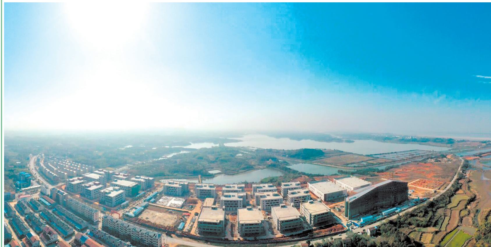
临湘工业园滨江产业区26万平方米标准化厂房PPP项目。
