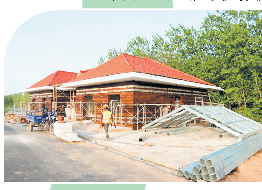
水利安保路项目施工现场。王志摄
