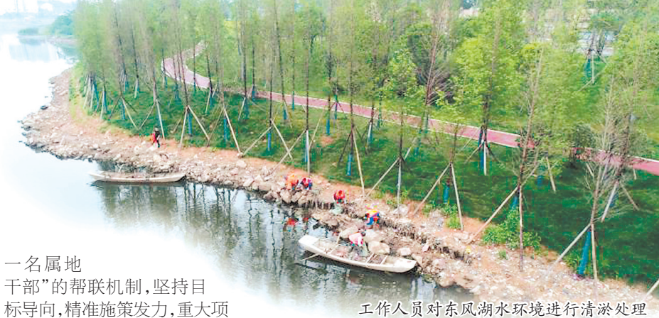
工作人员对东风湖水环境进行清淤处理
