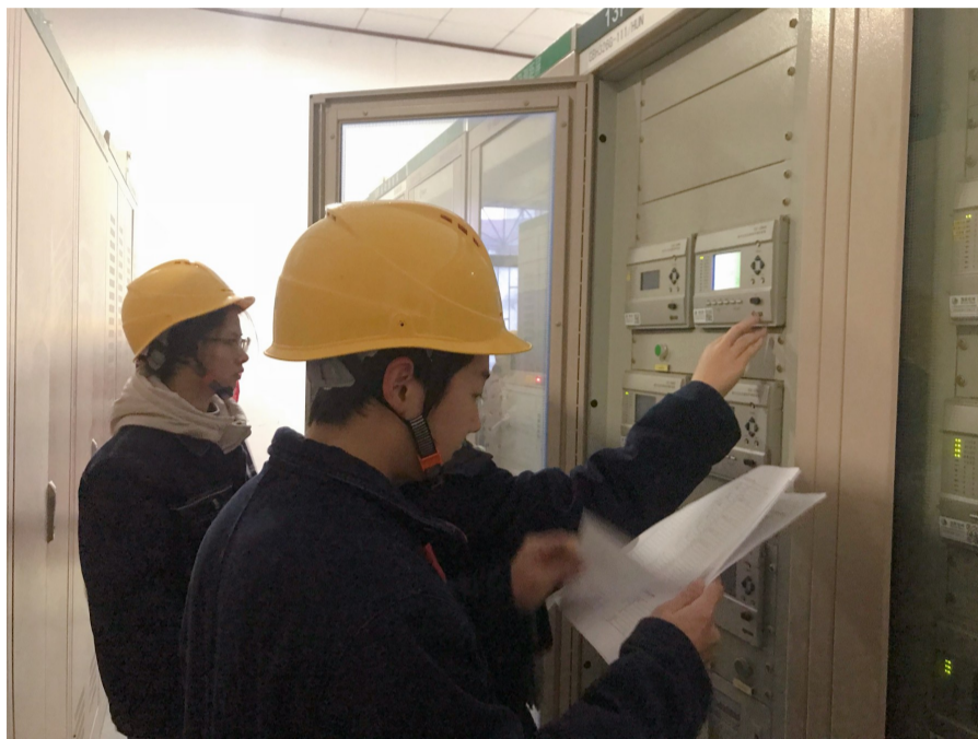
马壕变电站工作人员核对继电保护定值
