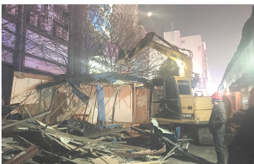
图为拆除现场。
