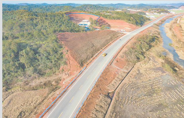
伸进了大山深处的S202线公路。
