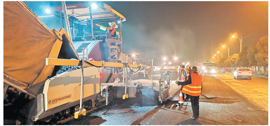
市市区公路建设和养护中心在联港路现代化全机器施工。
