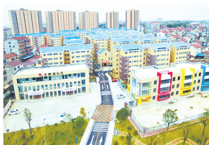
岳阳市2015年规模最大的保障性安居工程“春和家园”项目竣工。(资料图片)
