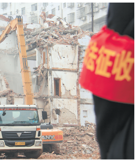
违建拆除违建现场
