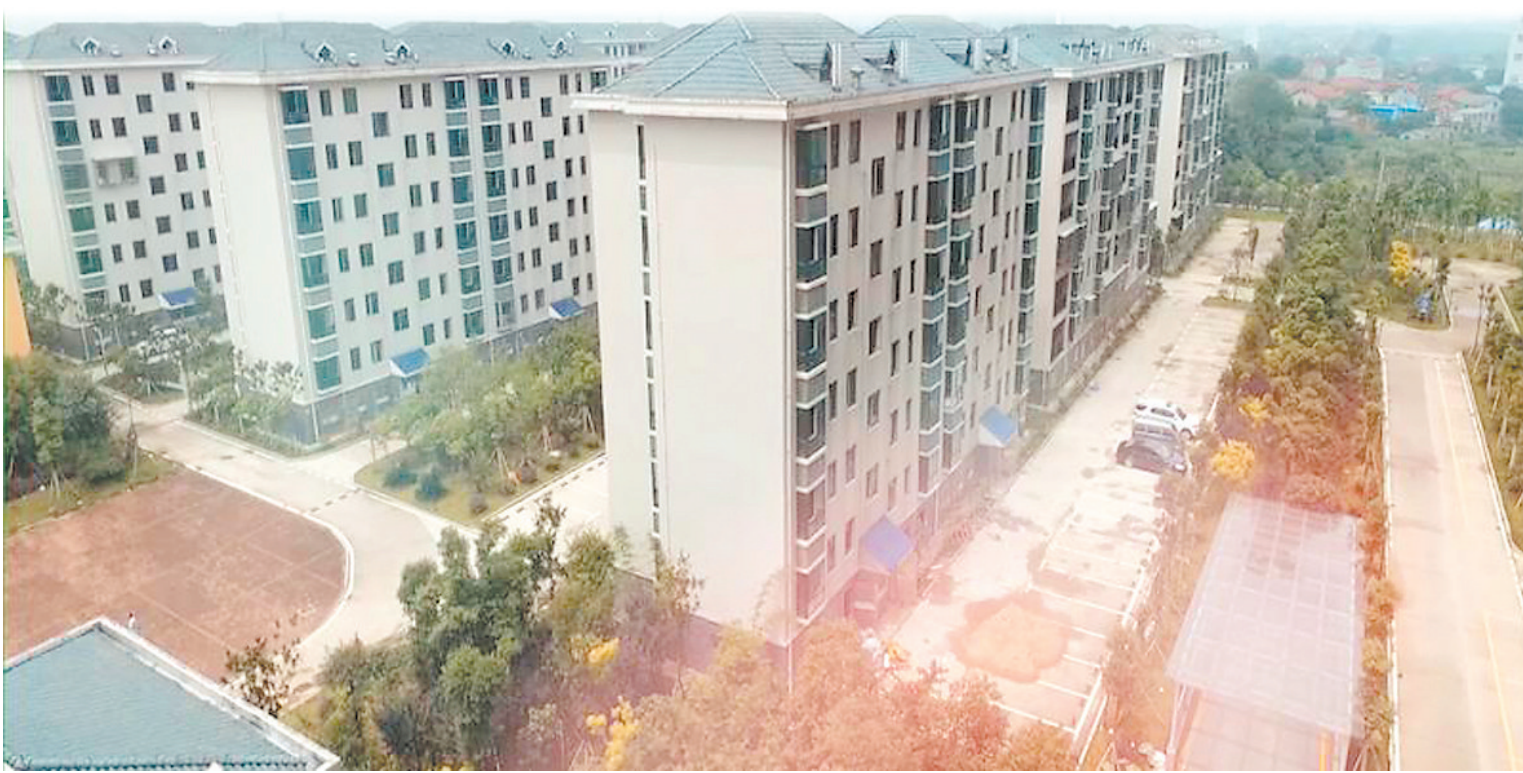
胥家桥安置房小区和兴家园
