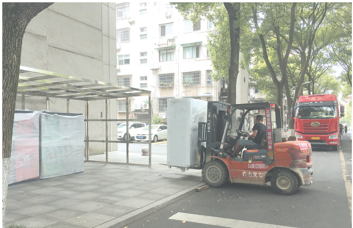
工作人员正在安装设备 谢凌摄
