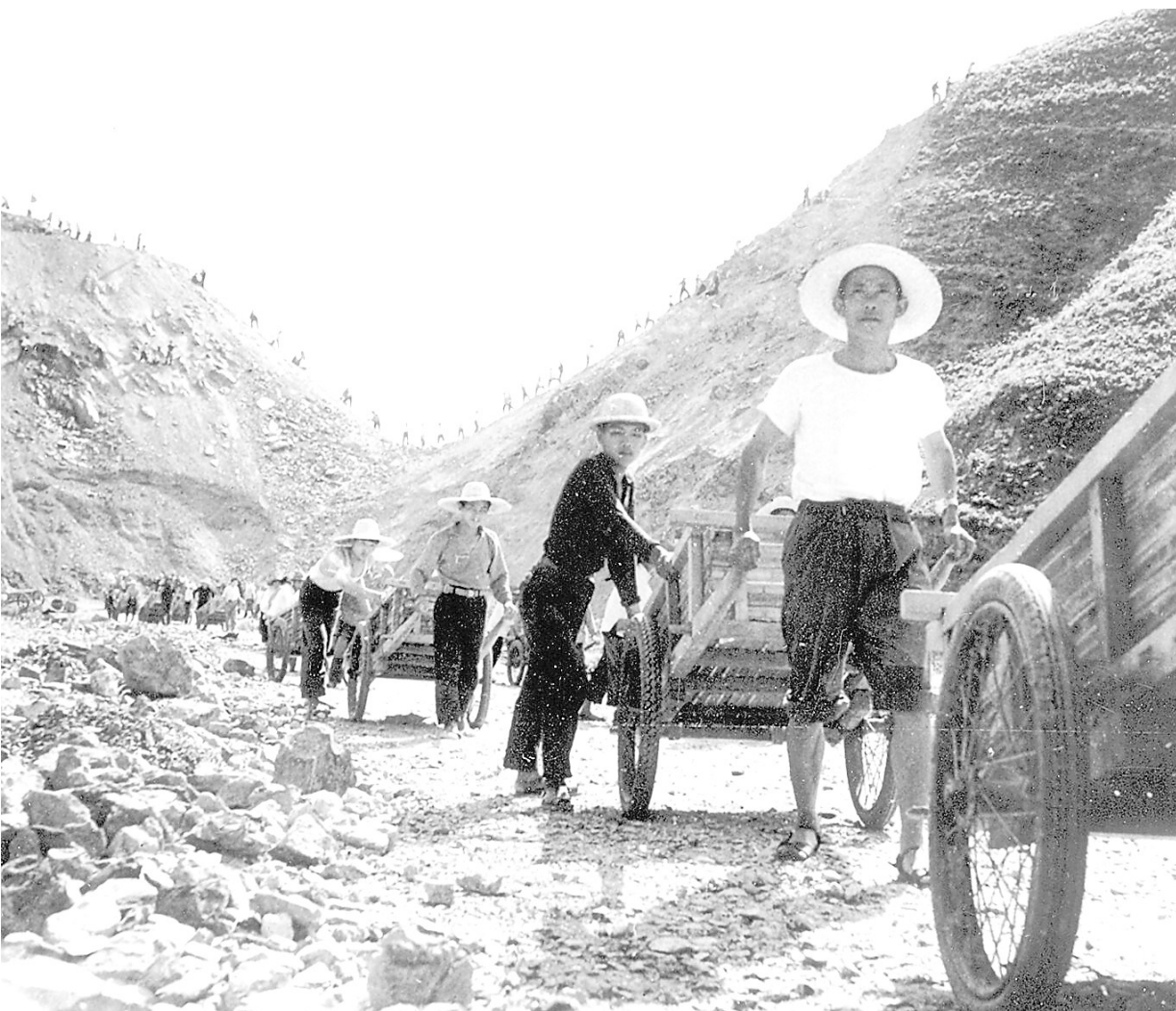
图为铁山水库当年施工现场(资料图片)
