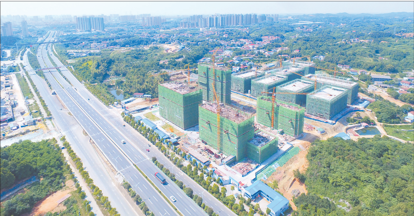
位于岳阳经开区的数博全球工业园预计今年10月底建成投产,将新增就业岗位2000多个,出口创汇1亿美元,年上缴税收超过3000多万元。图为正在建设的总部基地现场。
