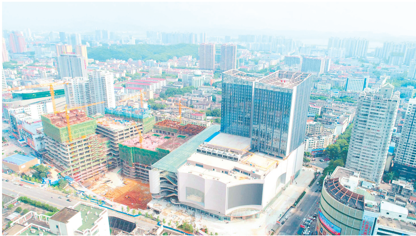
正在建设中的友阿·东茅岭商业综合体。李磊摄
