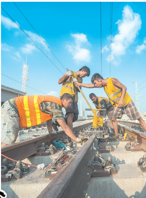
筑路工在枕木的螺丝孔上安装螺钎,确保加固护轨连接
