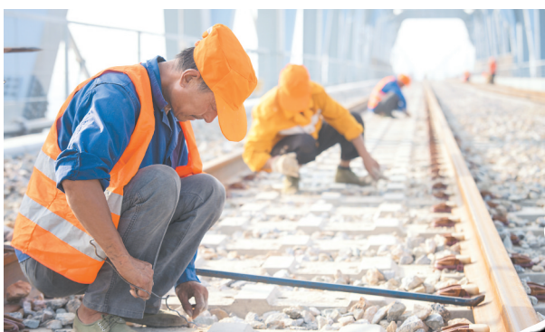
用钢纤将枕木上的每一个螺丝孔清理穿透
