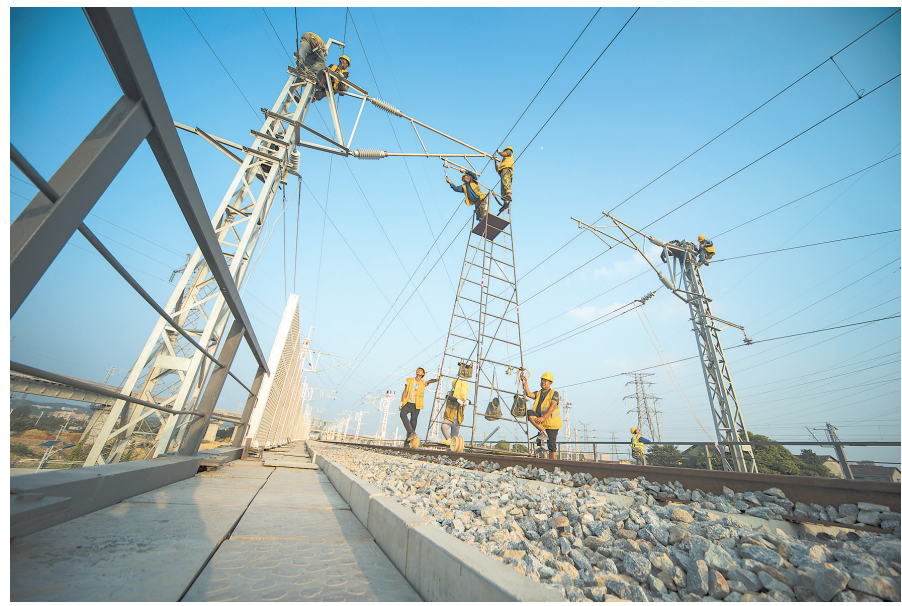
在铁路大桥上顶着烈日安装高压电缆
