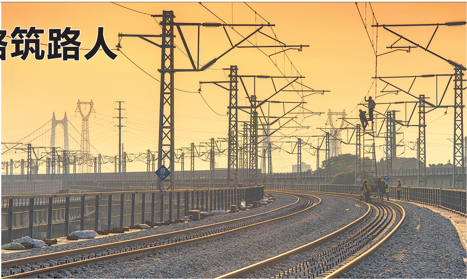
虽已黄昏,筑路工仍在高空作业
