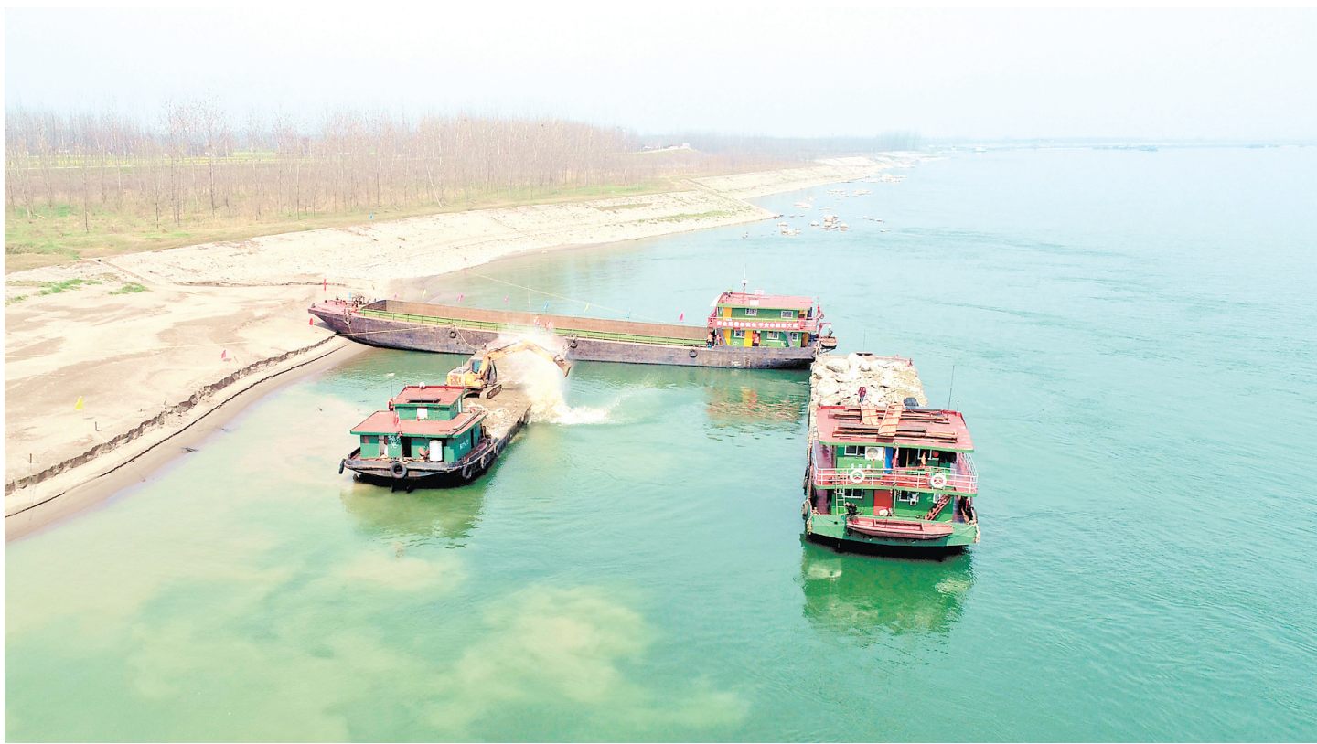
4至5月,华容县长江干堤天字一号堤段崩岸治理工程施工现场 袁道明 摄
