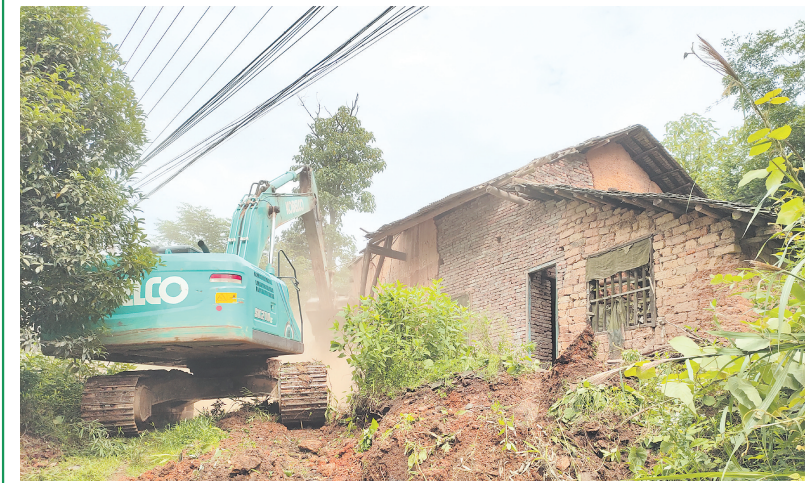
拆除“空心房”现场
