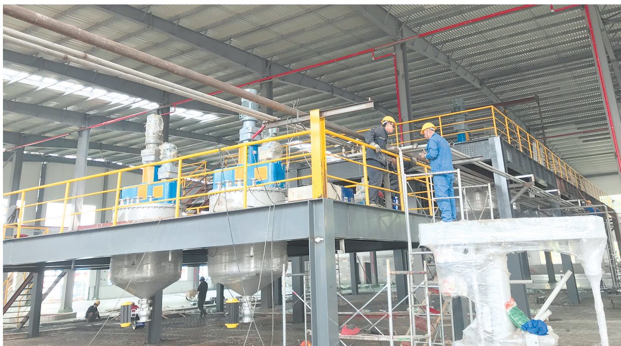
工人们在车间紧张有序地安装生产设备
