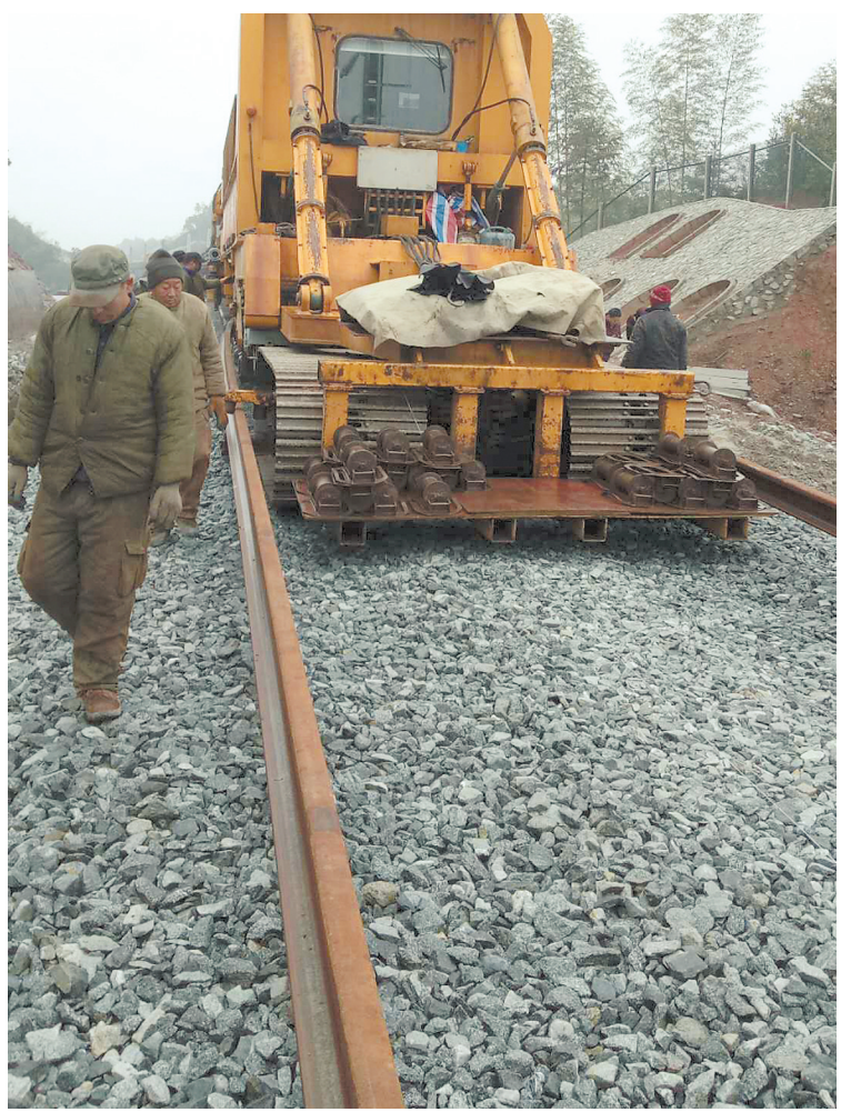
施工队铺设轨道 陈毅 摄
