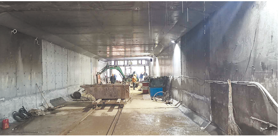
白杨坡地下过街通道工程主体结构施工现场
