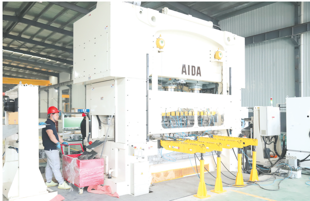
岳阳范斯特项目的第一台高速精密已经顺利完成安装调试,并生产出第一批合格产品。刘克宏 摄
