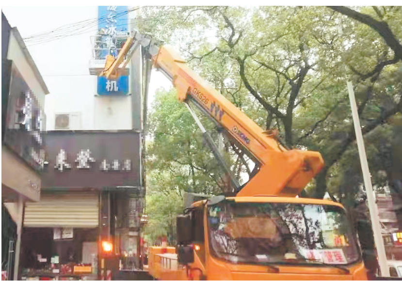
市城管执法人员正在排除空中安全隐患。
