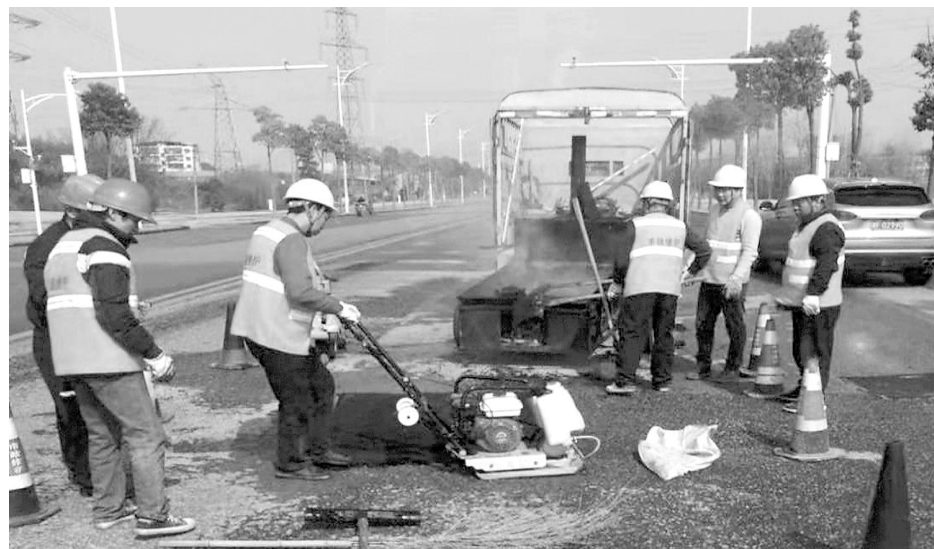
图为施工人员正在维护路面。记者 陈毅摄
