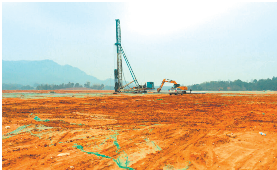
图为项目施工现场。
