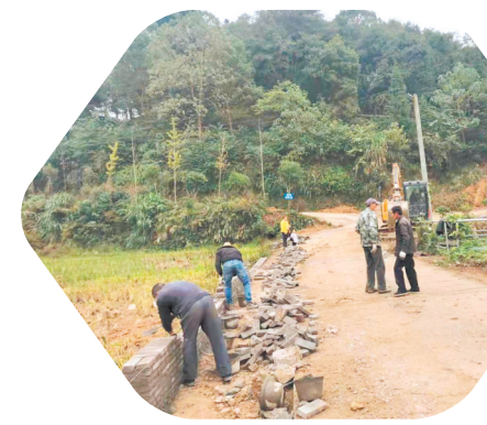
拓宽提质组级道路。
