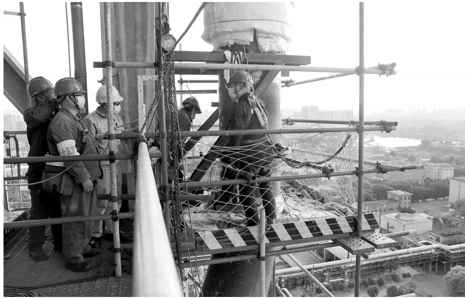
巴陵石化城区片装置大检修关键项目稳步推进。李翼骏 摄
