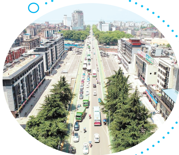
巴陵大桥市场提质改造成为城市更新的样板，城市“伤疤”华美蝶变。
