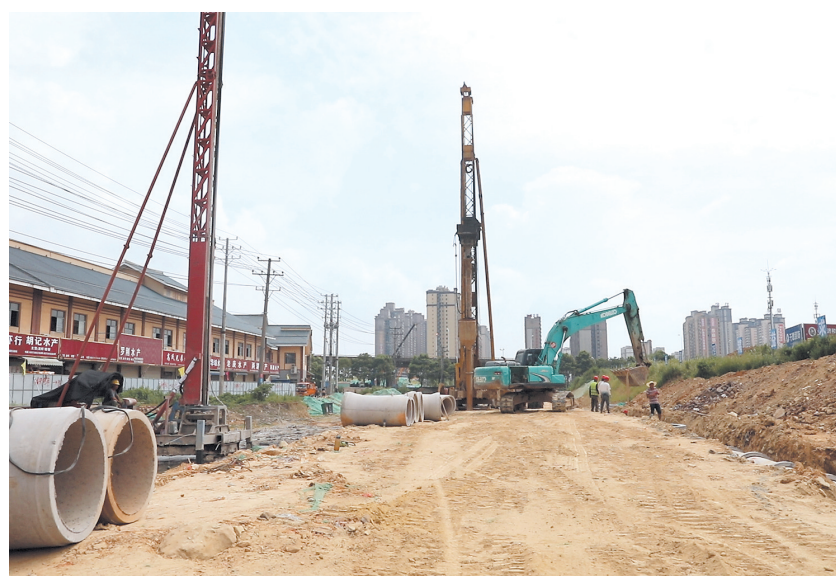
工人师傅们头顶烈日,正在进行污水管道铺设。记者 丁瑜摄
