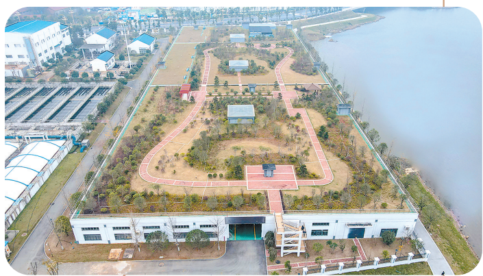
建成后的马壕污水处理厂。
