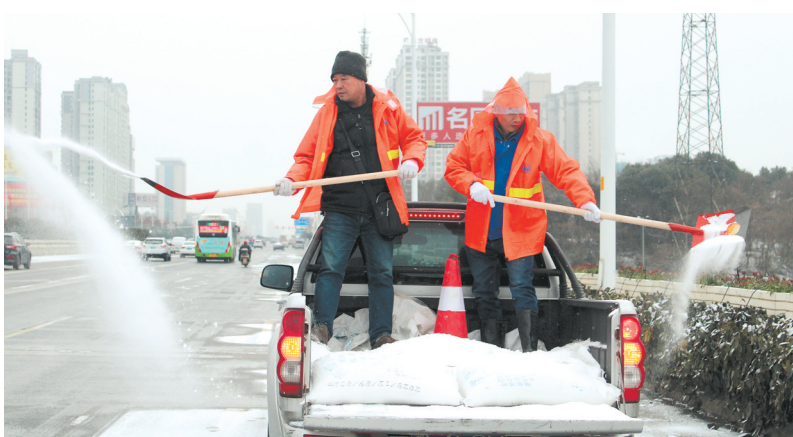
环卫工人对路面进行融冰、铲雪。
