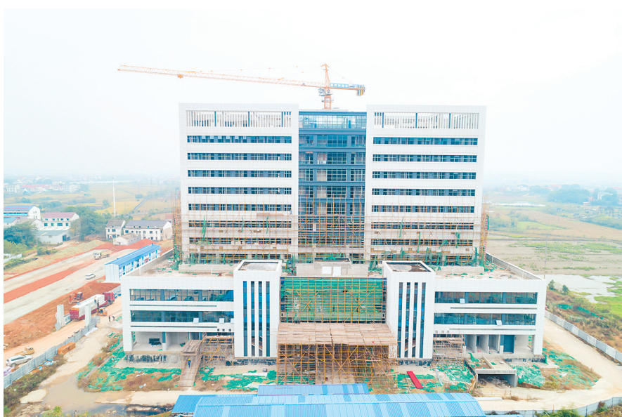
汨罗市妇幼保健院综合楼的主体及室外装修已经完工。
