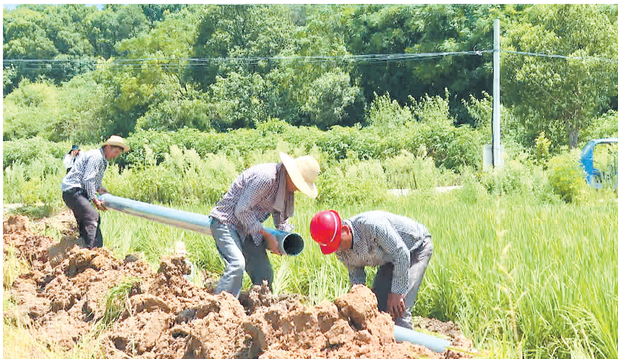
道仁村饮水提质改造工程施工现场。
