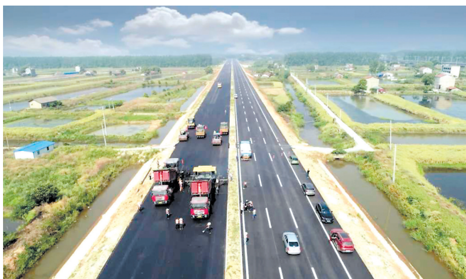
华容县交通项目建设施工现场。
