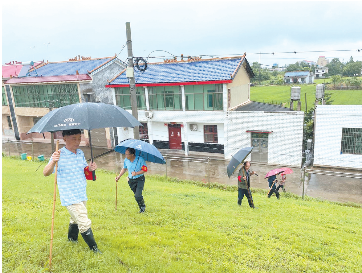
7月27日,湘阴县岭北镇党员群众冒雨在一线防汛大堤认真巡堤查险。记者 刘志恒 摄
