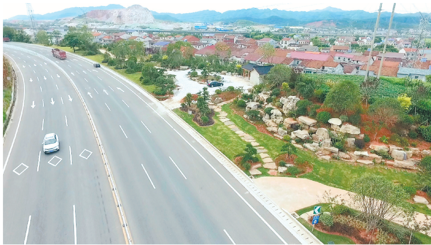
整治后的临湘城市西入口处,交通不再拥堵。
